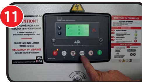
**FR :** Pour un groupe raccordé en démarrage «secours» appuyez sur le bouton « ». Le groupe ne démarrera qu'en cas de coupure du réseau local
