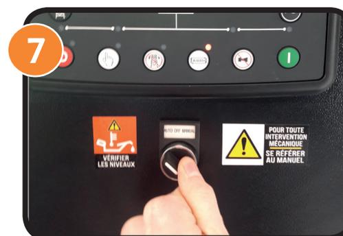
**FR :** Pour un groupe raccordé en démarrage « secours » passer le commutateur sur le mode « Auto ». Le groupe ne démarrera qu'en cas de coupure du réseau local.
