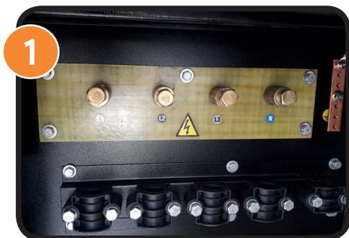
**FR :** Raccordement du bornier électrique (L1, L2, L3, N et Terre)
